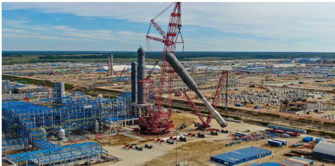
Рис. 4. Начало монтажа оборудования на Амурском ГПЗ. Фото С.Р. Овчарова.
