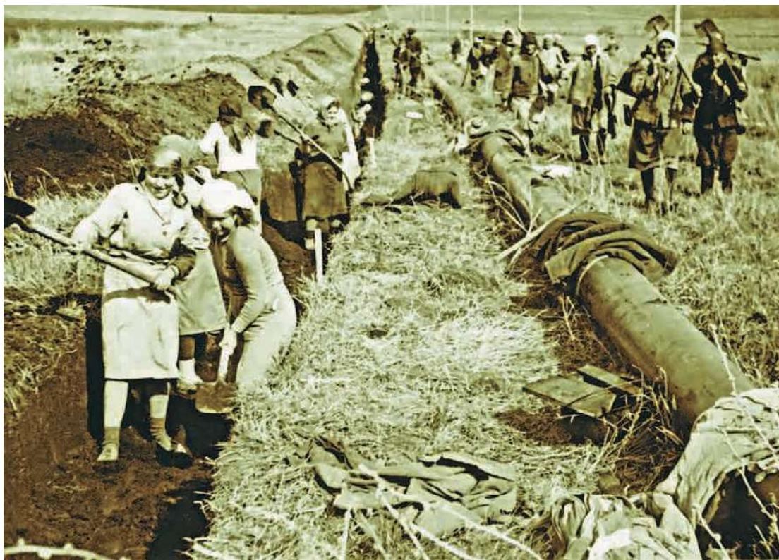
Прокладка трассы первого газопровода Саратов – Москва
