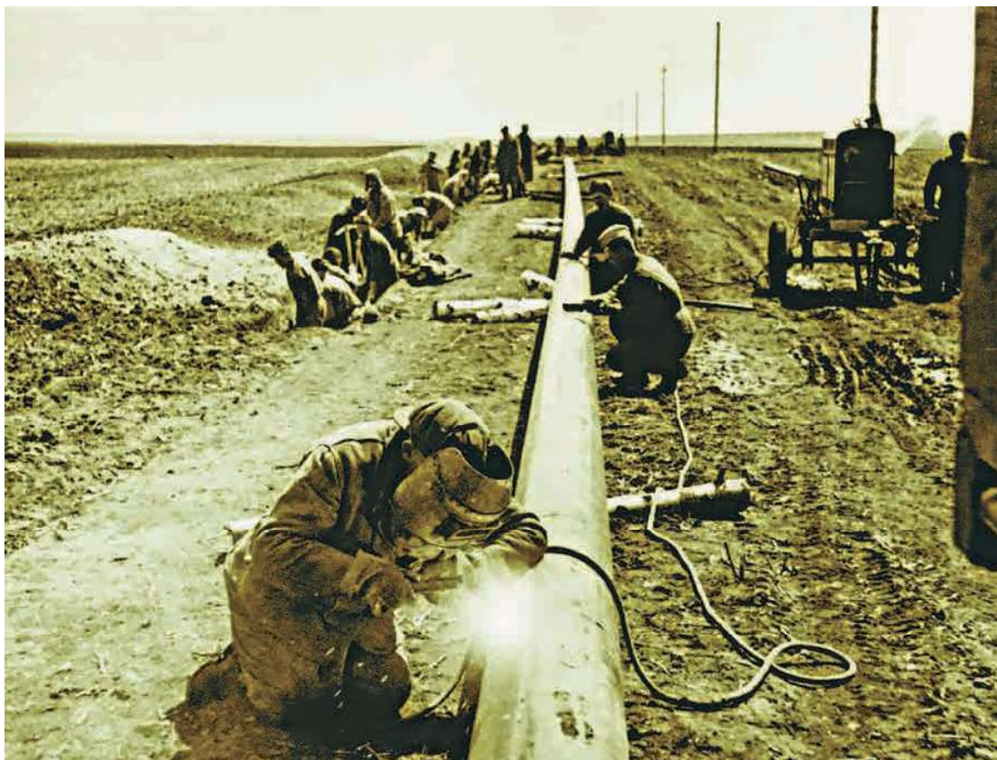
Сварочные работы на первом газопроводе
