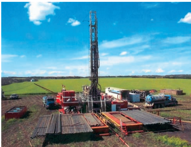
Рис. 1. Расположение оборудования при бурении установкой RD-20II с промывкой буровым раствором
