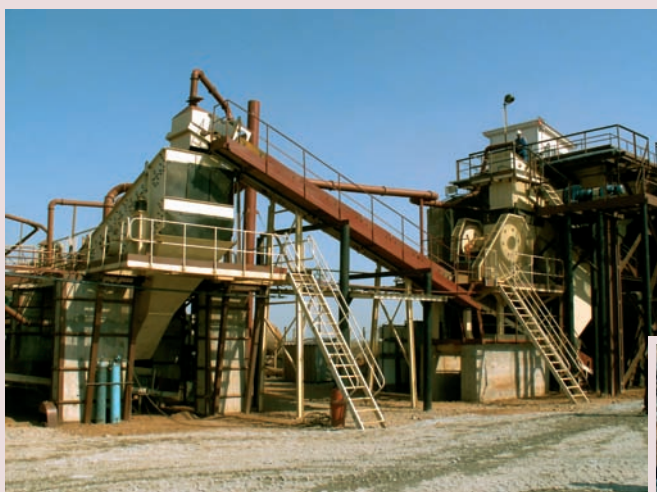
Дробильно-сортировочный комплекс участка кучного выщелачивания
