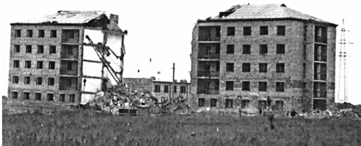
Рис. 1. Здание, разрушившееся вследствие подтопления в процессе строительства (фото автора).
