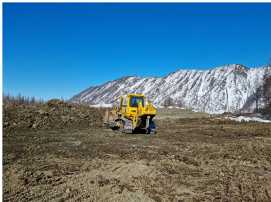
Рис. 1. Вскрыша торфов бульдозером на россыпном месторождении золота Лазо.
