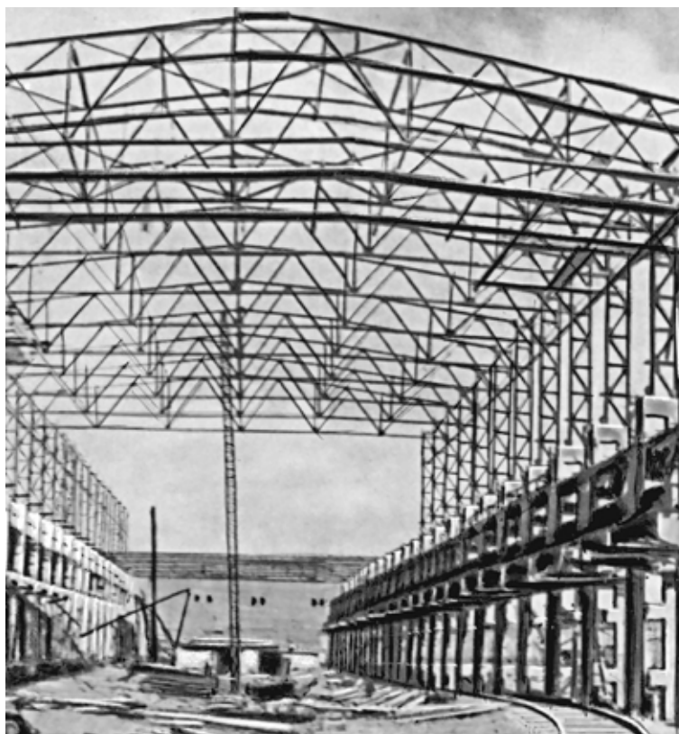
Рис. 4. Строительство оборонного завода на Урале. 1941 г.
