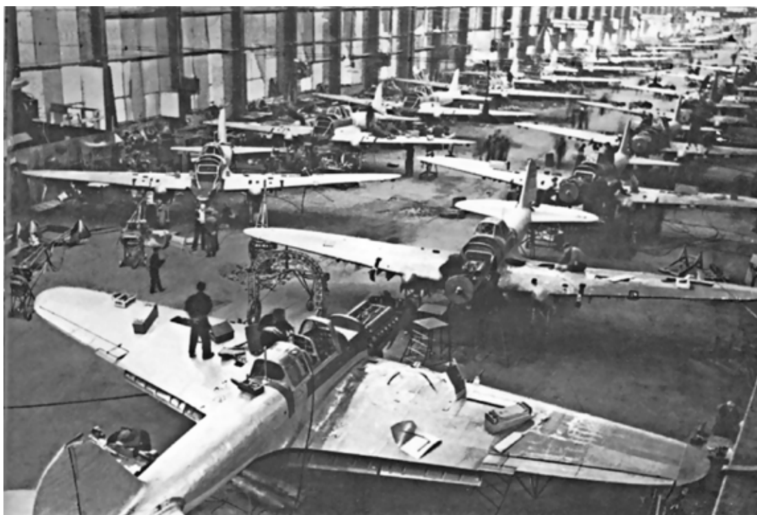
Рис. 6. Оборонный завод в Новосибирской области
