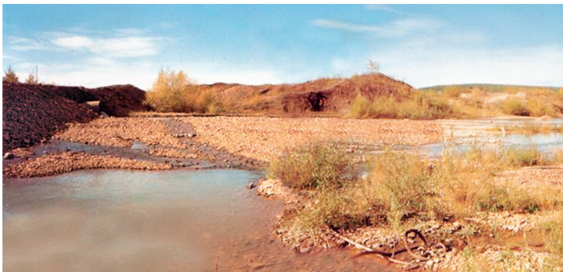
Рис. 2. Перелив сточных вод из хвостохранилища Куранахской ЗИФ
