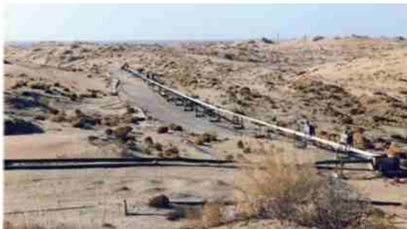
Поверхностный комплекс подземного выщелачивания
